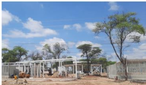
Avances de obra – PORTICO DE INGRESO
