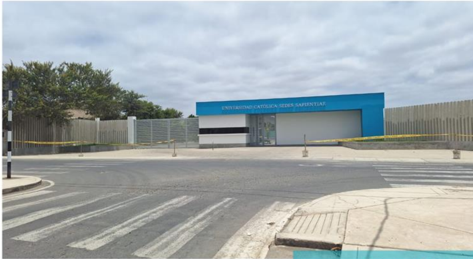
PORTICO DE INGRESO ACTUAL
